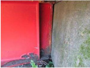
主桁端部の腐食および遊間異常
