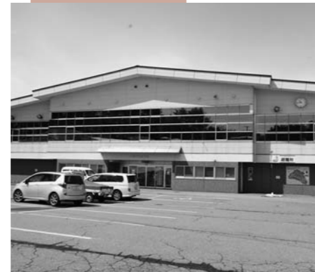
耐震改修工事が行われる市体育館
