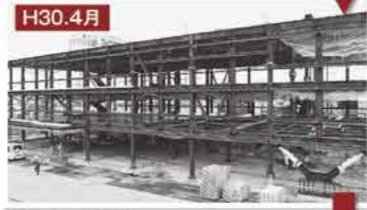
H30.4月 鉄骨建て方が完了。
