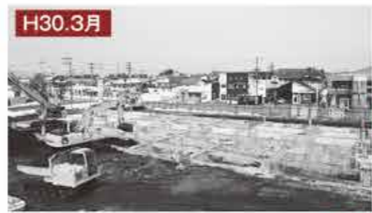
H30.3月 基礎を埋め戻す作業を行っています。
