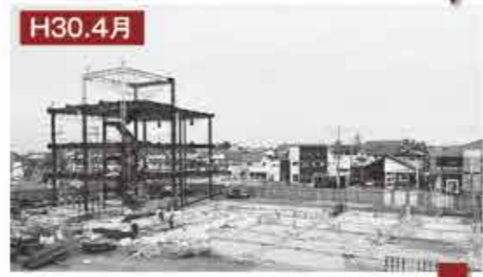
H30.4月 鉄骨の建て方が始まりしました。
