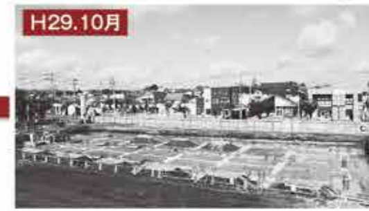
H29.10月 基礎コンクリートが打設されました。
