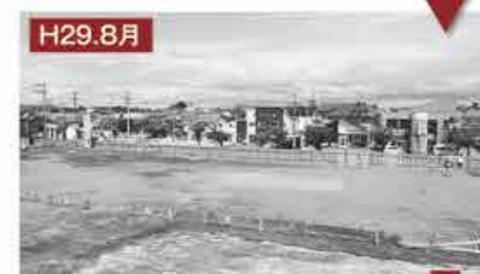
H29.8月 工事敷地を区画するバリケードが設置されました。
