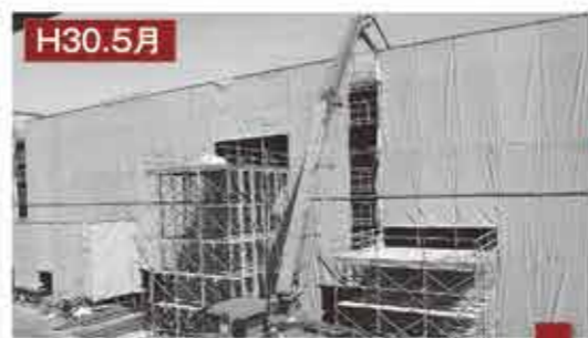
H30.5月 養生シートで覆い、屋上のコンクリート打設作業を行っています。
