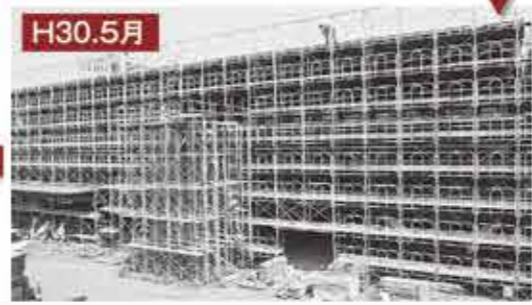
H30.5月 足場が設置されました。
