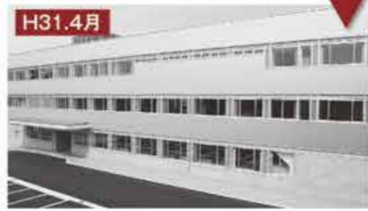
H31.4月 駐車場の舗装が終わり完成。
