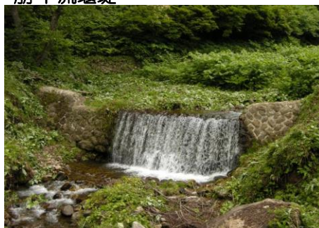
くすれかりゅうえんてい 崩下流堰堤
