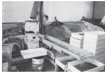
北海道芽室町のペレット製造所の稼働様子
