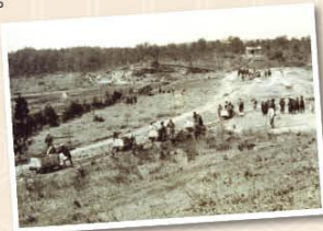
徳良湖 築堤工事の様子
