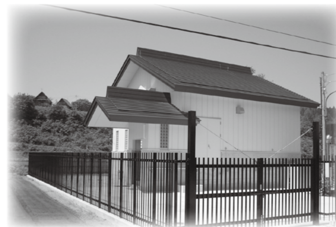
尾花沢市簡易水道 鶴子浄水場
