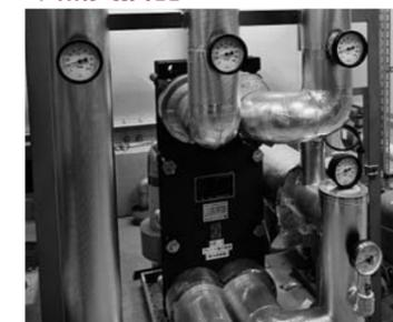
▲雪がとけてできた融解水の冷熱と外気の熱を交換器内で調節し、適度な温度の冷気を庁舎へと送ります。
