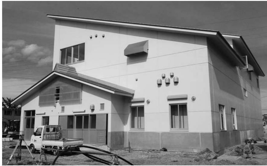
建設途中のし尿処理施設(撮影:6月27日)
