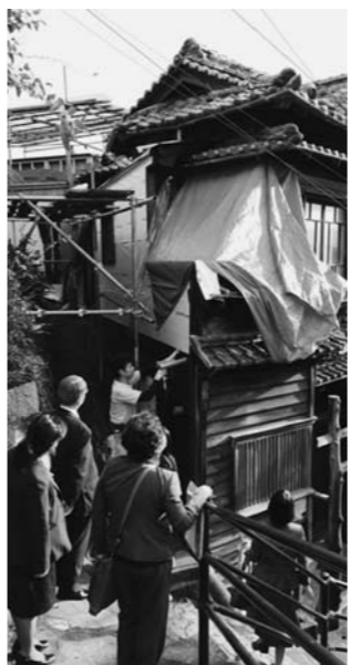
尾道市の空き家再生中
