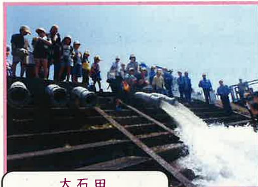
大石田 第五排水樋管 実際に排水ポンプ車を使って 水を放しました。
