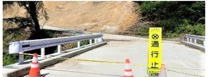
ハリマ林道の復旧工事ですが、崩れた土砂の撤去が完了し、法面の保護工の準備にとりかかっていますので、予定通りに9月いっぱいまで完成できるものと思われます。もうしばらくご不便をおかけしますが、現場の指示に従い、工事が安全に進められるようご協力をお願いします。
