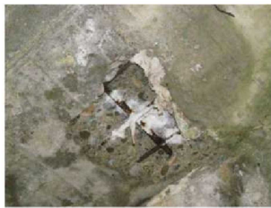
床版コンクリートの剥離・鉄筋露出、遊離石灰
