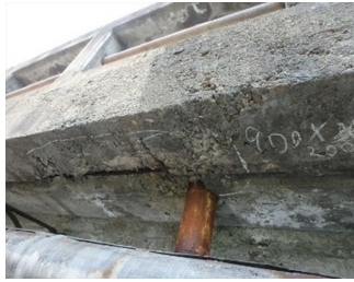
主桁コンクリートの剥離・鉄筋露出
