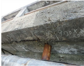
主桁コンクリートの剥離・鉄筋露出
