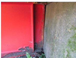
主桁端部の腐食および遊間異常
