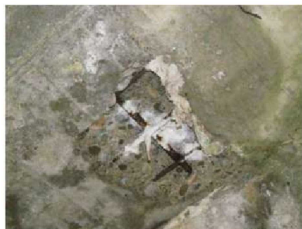
床版コンクリートの剥離・鉄筋露出、遊離石灰
