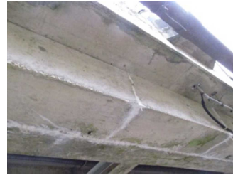
主桁ひび割れ
