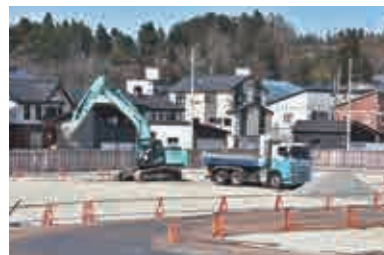
建築工事が進む新しい尾花沢小学校
