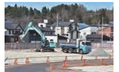
建築工事が進む新しい尾花沢小学校
