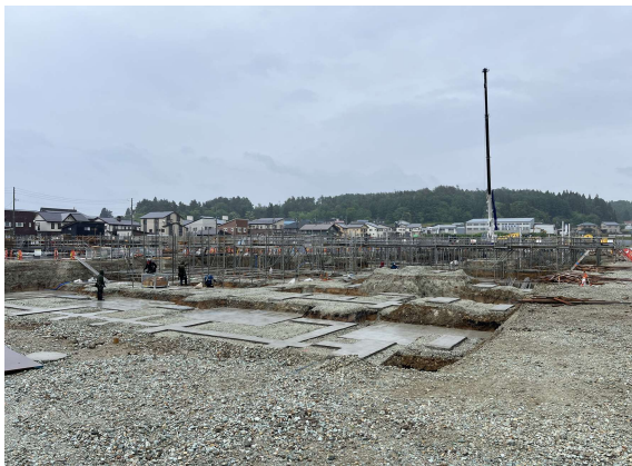
校舎棟の基礎工事。掘削作業も完了し東側から工事を進めます。基礎工事用の通路足場を設置しています。
