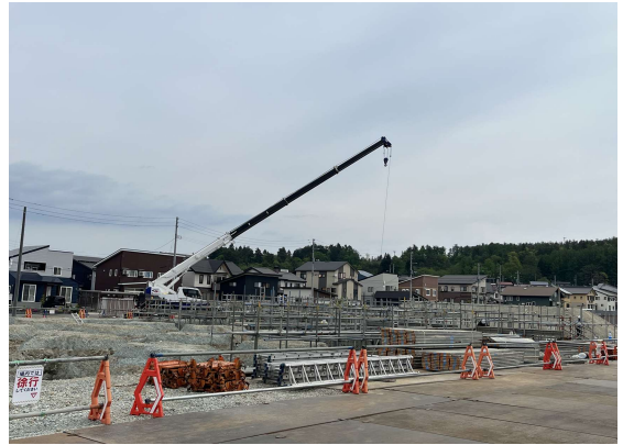
クローラークレーンとこのラフタークレーン（移動用エンジンを搭載し高い機動力を発揮する移動式クレーン）で材料の振り分けを行います。
