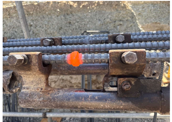
体育館棟の基礎鉄筋工事。職人さんの匠の技できれいに接続されました。まだ鉄筋が赤く熱をもっています。
