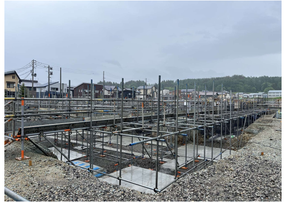
体育館棟の基礎。基礎工事用の通路足場を設置しています。
