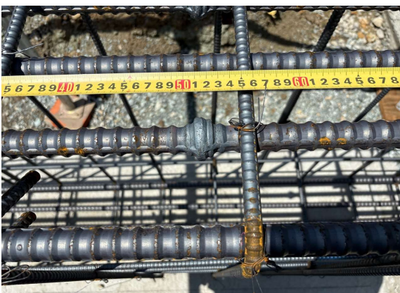
体育館棟の基礎鉄筋工事。きれいに配筋作業も行います。
