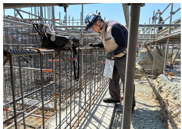
体育館棟の基礎鉄筋工事。圧接箇所の不具合がないか、専門検査員が超音波を使用し確認します。
