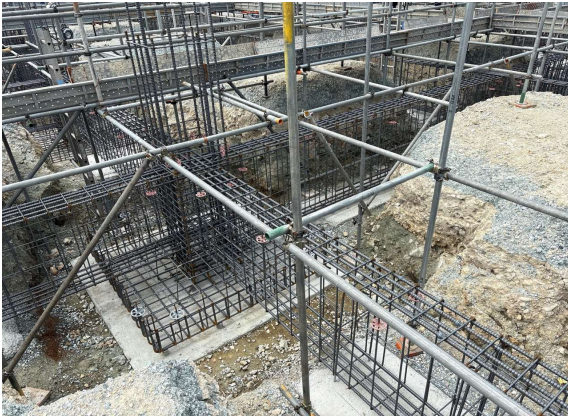
体育館棟の基礎鉄筋工事。基礎の鉄筋がきれいに組み立てられました。
