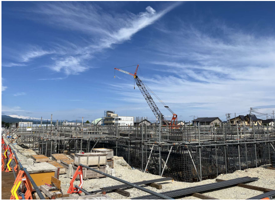
クローラークレーンの作業状況。
