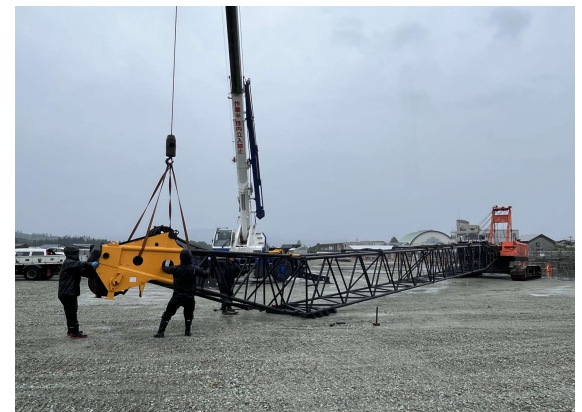
クローラークレーン組み立て。クローラークレーンの腕（ラチスブーム）の組み立てをラフタークレーンで行います。
