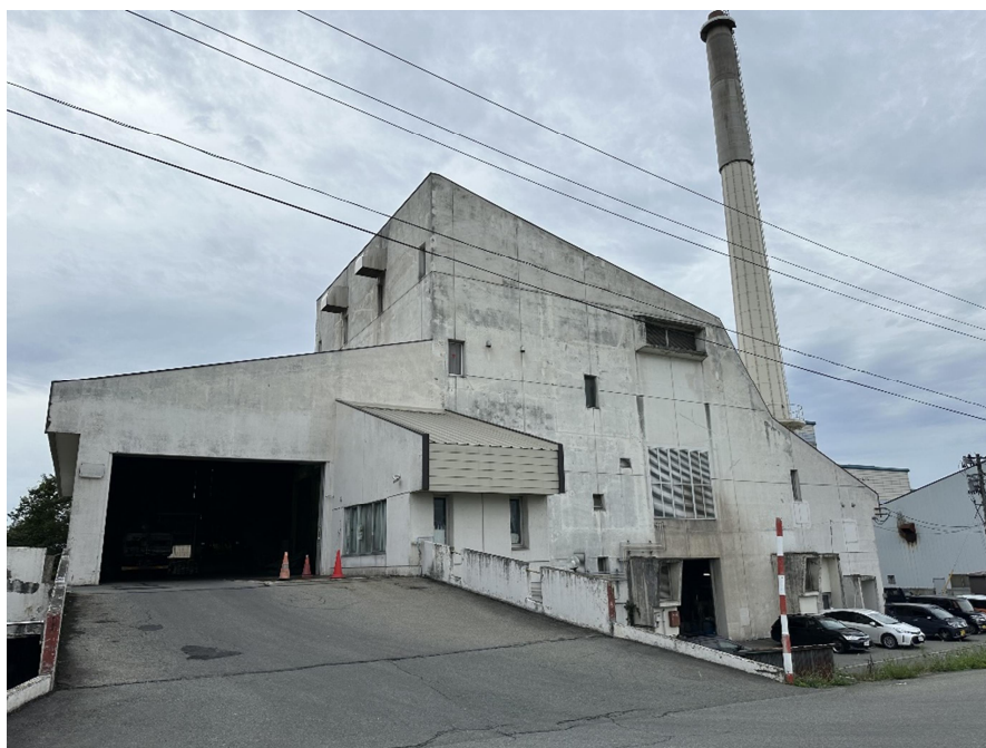
老朽化したごみ焼却施設の写真
