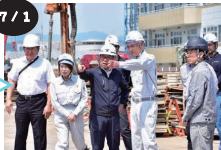
新しい尾花沢小学校の建設現場を視察
