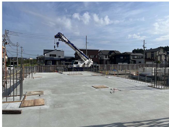
【体育館棟 1 工区：土間・スラブコンクリート打設】 きれいな床が出来上がりました。
