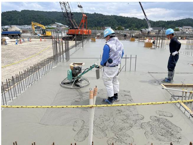
【体育館棟 1 工区：土間・スラブコンクリート打設】 床コンクリート均しは機械を使用して丁寧に均していきます。
