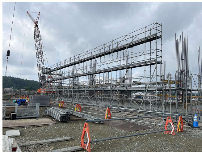
【体育館棟：外部足場組み立て】 外部の工事を行うために足場を組み立てます。
