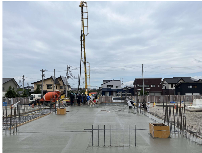
【体育館棟 1 工区：土間・スラブコンクリート打設】 鉄筋の組み立てのあと、コンクリートを打設します。
