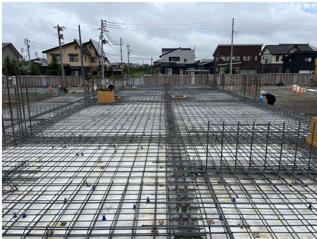
【体育館棟 1 工区：土間・スラブ鉄筋組立】 基礎工事が完了し、1 階床の工事の準備に入ります。
