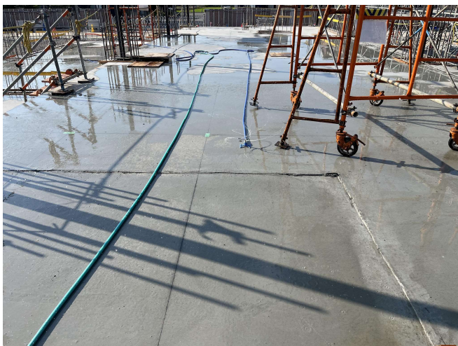
【体育館棟 1 工区：土間・スラブコンクリート打設】 コンクリート打設後に乾燥によるヒビ割れを防ぐため散水を行います。
