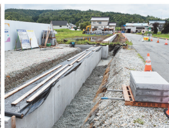
▲設置作業中の自由勾配側溝
