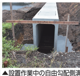
▲設置作業中の自由勾配側溝
