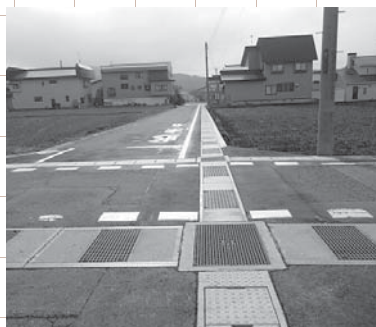
今年度完成した若葉町の流雪溝。
