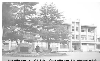
尾花沢小学校(尾花沢代官所跡)
