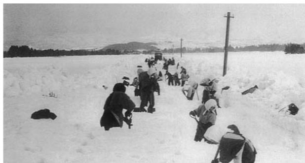
▲一晩で1メートルを超す積雪により埋まった線路。人力で除雪し、線路を掘り出す。冬、男性は出稼ぎのため女性が多かった。
