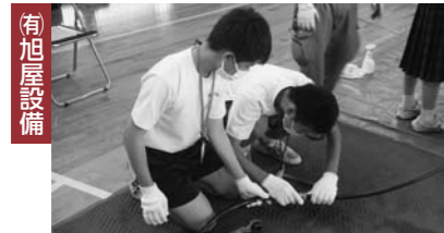
有旭屋設備 ▲流し台に排水管の取り付け作業を行いました。技術を教わりながら協力し合って排水の配管に挑戦。水漏れすることなく設置できました。
