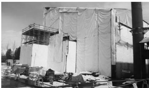
建設中のし尿処理施設 (H28年1月)
