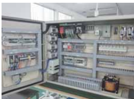
当社から生みだされた省力設備
